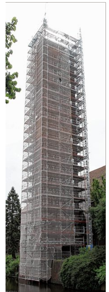
Verschleiert: Der Turm ist eingerüstet und verhüllt.
